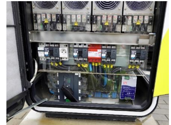
Anschlussteil einer Ladestation mit 4 DC- Modulen
